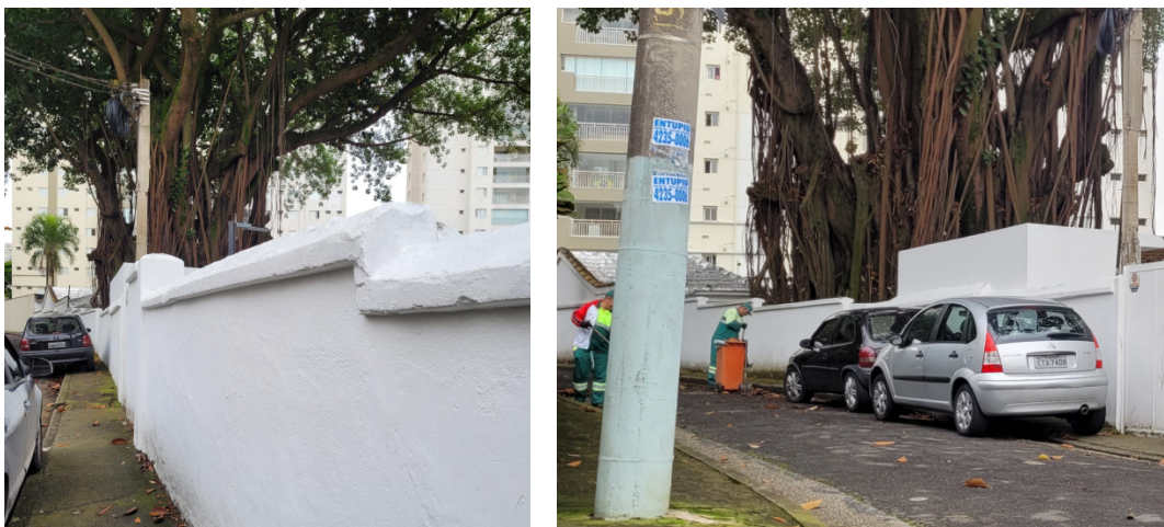
Parte do local indicado pela Sra. Glauci para instalação das grades. Foto: Mônica Nunes (19;10;22)
