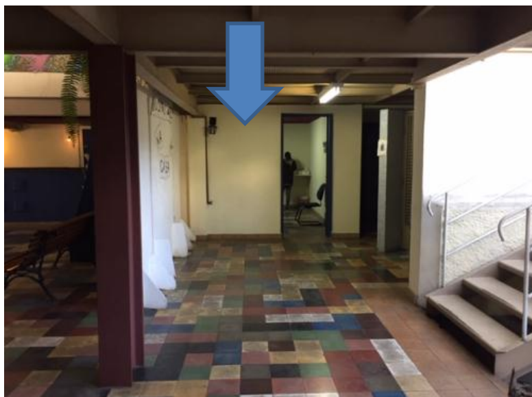
Local para instalação de Dry-wall – Reg. Fotográfico em 04.07.2022
