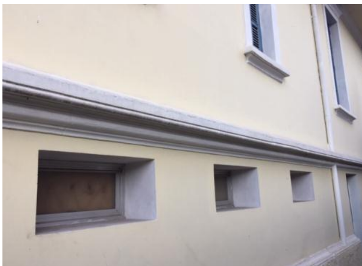
Janelas dos WC´sDep. do Pav. Térreo - Registros fotográficos em 04.07.2022
