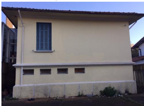
Janelas dos WC's do Pav. Térreo - Registros fotográficos em 04.07.2022.
