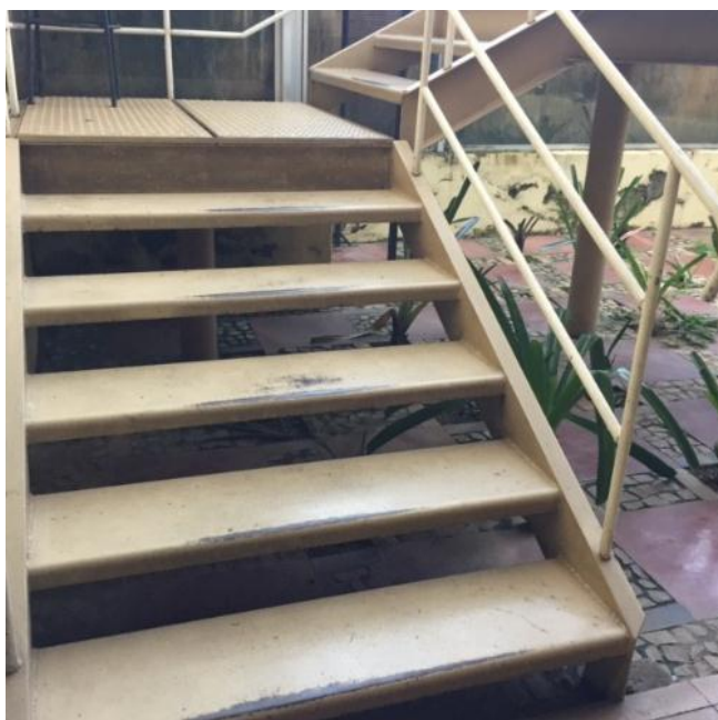
Escada metálica – Registro fotográfico em 04.07.2022
