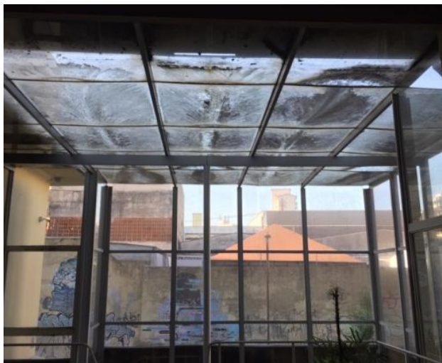
Estrutura de metal e vidro (vista interna)- Reg. fotográficos em 04.07.2022.
