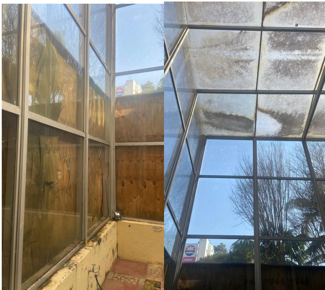
Foto 6 e 7 – Vista de dentro do foyer – vidros quebrados e toda estrutura degradada
