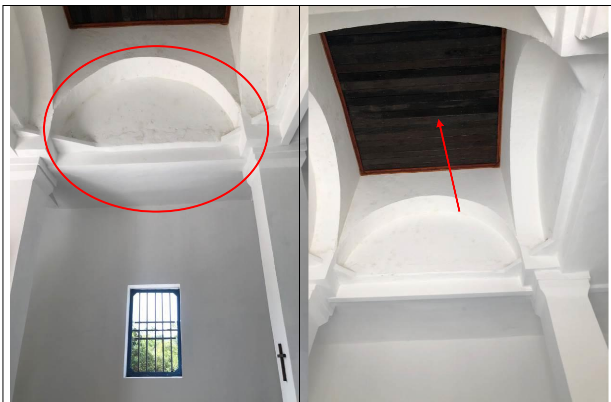
Foto 6 e 7 – Vista interna da capela, notar sinais de afloramento de manchas na parte superior da parede. Foi instalado foro de madeira no nicho superior que contém a estrutura que suporta a estátua existente acima da Capela. Foto Fátima Tavella, 19.09.2022.
