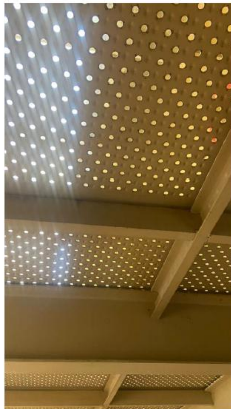
Foto 2 – Mezanino – Projeto para nivelar piso ( acessibilidade ) e troca de piso perfurado metálico.
