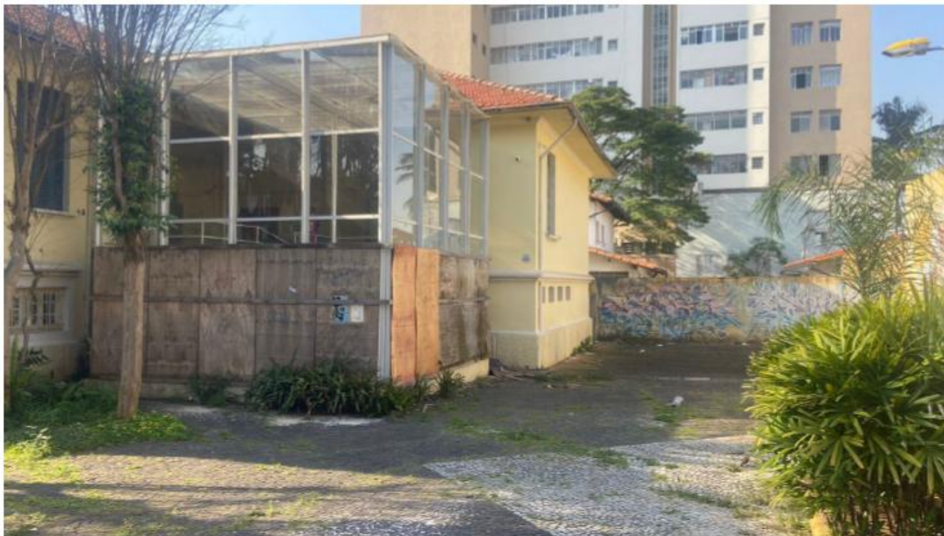
Foto 1 – Área externa - estrutura de vidro “protegida” por tapume para evitar vandalismo e invasão.
