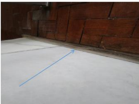
Rodapé em madeira (destacada)
