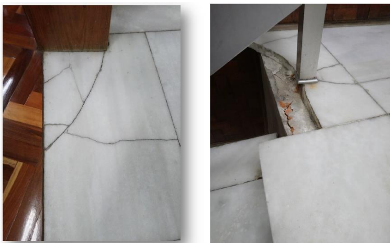
Patamar e escada
