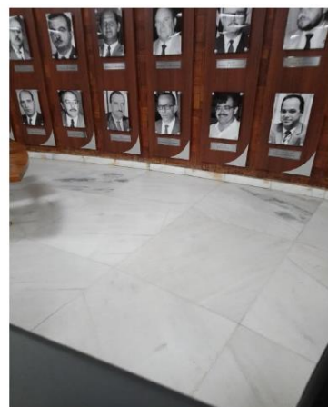
Piso salão pav. térreo.
