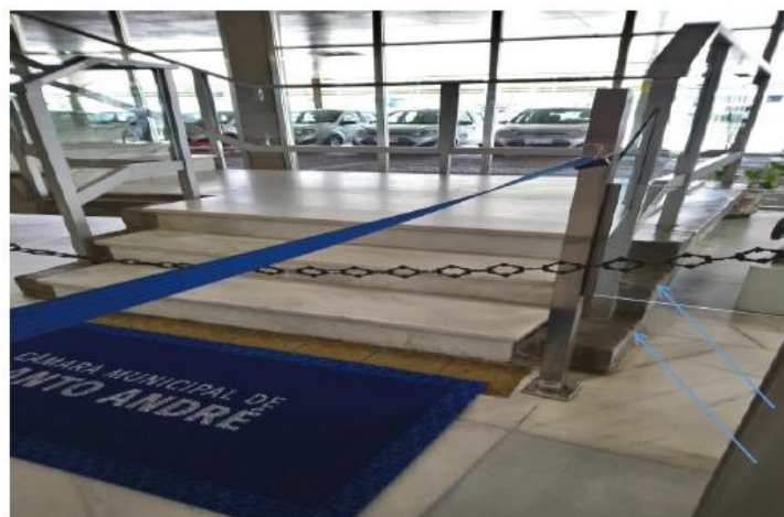
Elemento de concreto (destaque)
