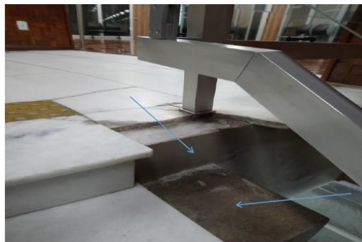
Elemento de concreto (destaque)
