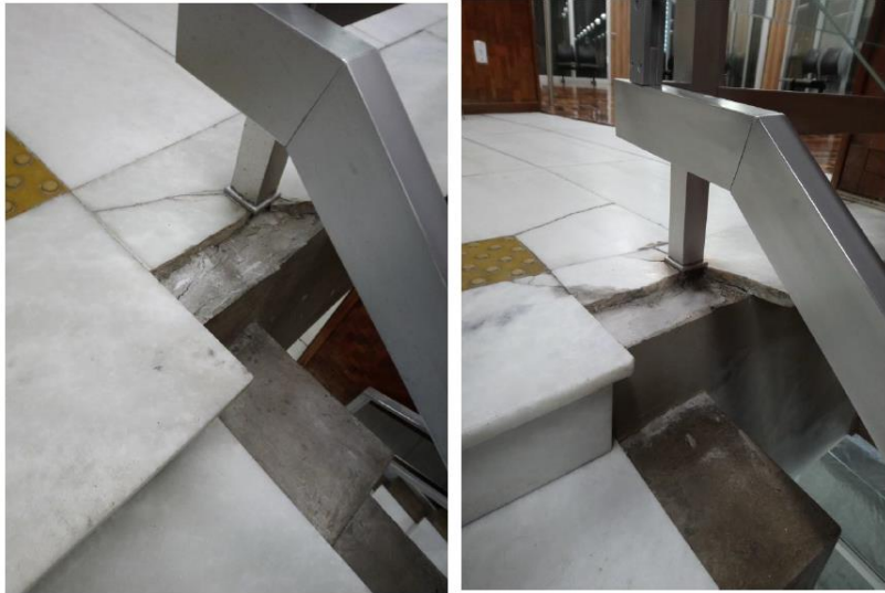
Escadas e elementos em concreto
