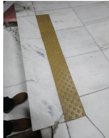
Escada, patamares, elemento de concreto e piso tátil
