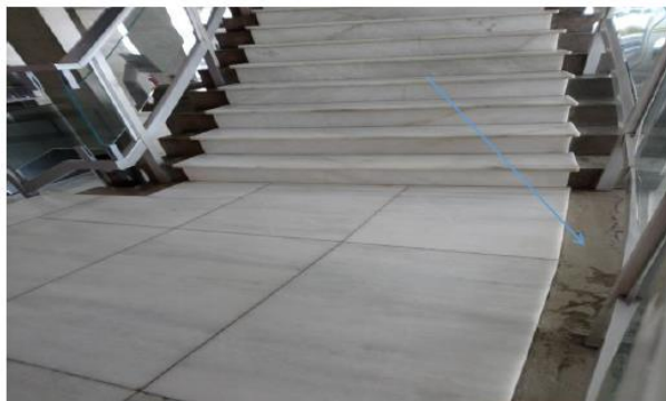
Partes em concreto (destacada)
