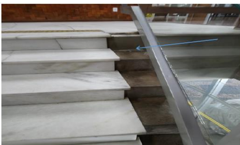
Elemento de concreto (destaque)
