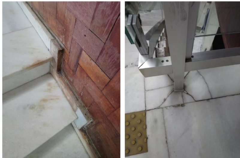
Escadas, rodapés e patamar
