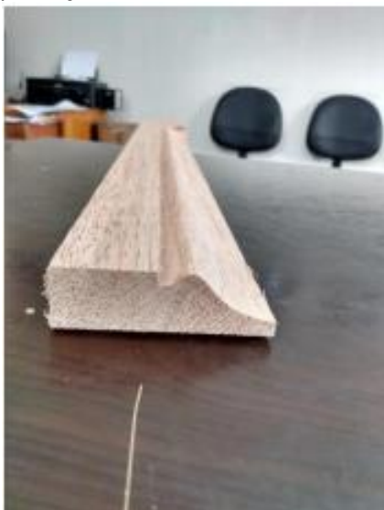
Figura 1: Guarnição reproduzida com desenho diferente do remanescente, notar que há somente um rebaixo na madeira.
