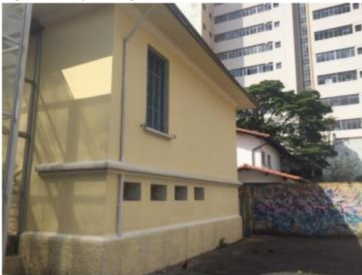
Fachada dos fundos com 04 janelas dos banheiros Atualmente sem grades Foto 01 Janelas dos banheiros –
