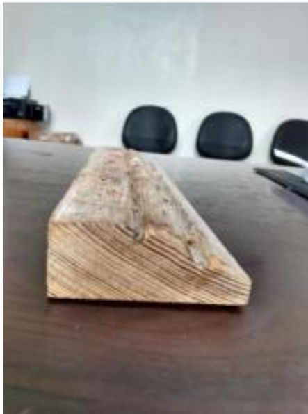
Figura 2: Peça remanescente da guarnição com três rebaixos, notar a diferença entre os desenhos.
