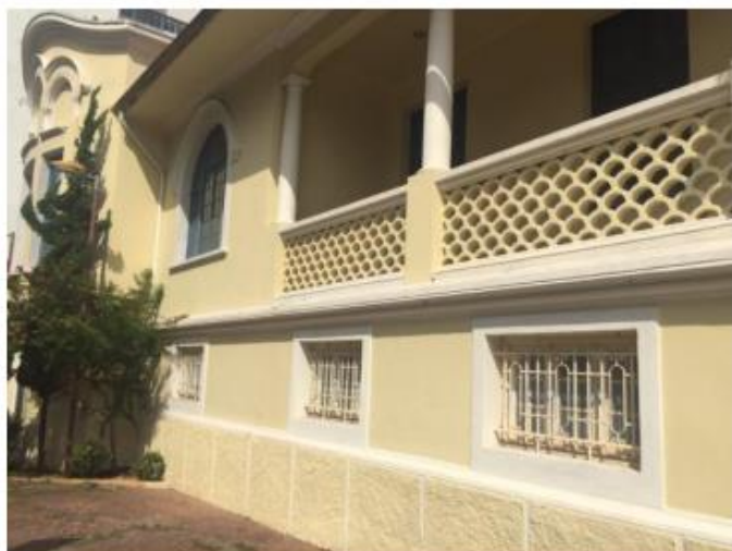
Foto 05. Grades das janelas do pavimento térreo da fachada frontal na cor amarelo claro
