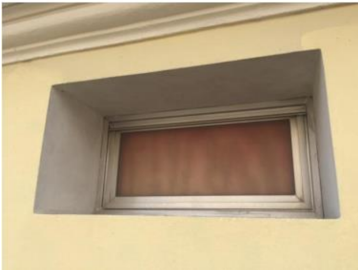
Foto 03. Estrutura em alumínio natural Grade na cor amarelo claro Os elementos metálicos existentes são na cor amarelo claro ou alumínio natural
