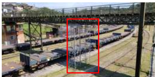
Foto 05: Elemento para escoramento da passarela visto a partir do acesso para a Parte Baixa, 16.11.2021.
