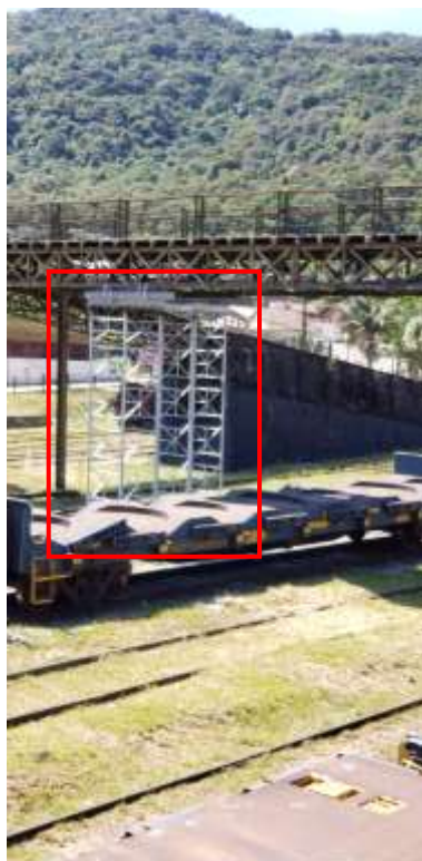
Foto 06: Elemento para escoramento da passarela visto a partir da plataforma da 2ª Estação, 16.11.2021.
