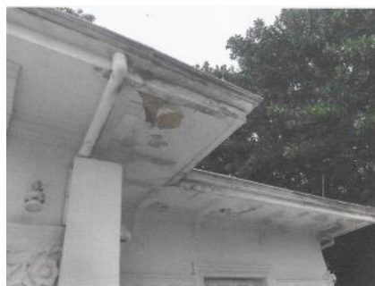
Imagem 04 - Beiral 02 – Fonte: Laudo do Telhado
