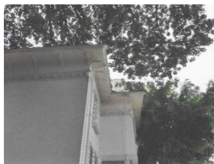
Imagem 06 – Fonte: Laudo do Telhado
