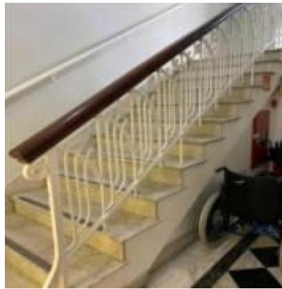
Corrimão metálico fixado na parede Foto – Fls. 134 – PA 16768/2018
