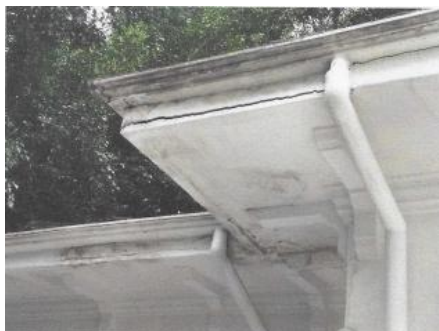
Imagem 03 - Beiral 01 – Fonte: Laudo do Telhado
