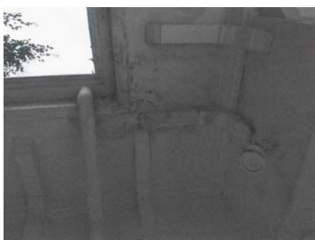
Imagem 05 – Fonte: Laudo do Telhado
