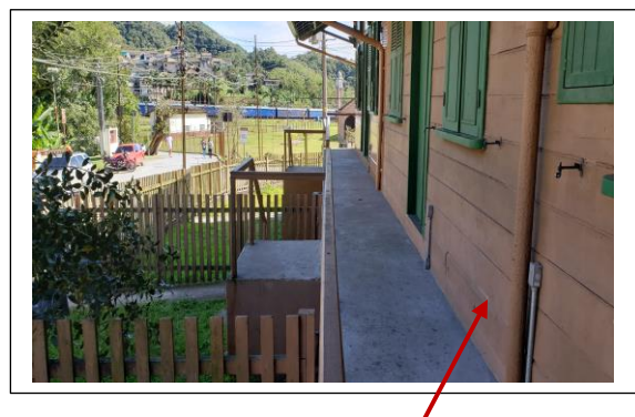
Figura 2. Detalhe da fachada principal da edificação sita à Avenida Manoel Ferraz de Campos Salles nº451. Observe-se o acabamento fosco ou acetinado na pintura da edificação vizinha, nº452, que não tinha recebido nova pintura até o momento da vistoria. Foto SK, 19.07.2021.
