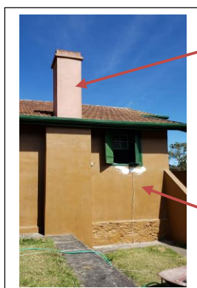
Figura 6. Fachada posterior da edificação sita à Avenida Manoel Ferraz de Campos Salles nº451. Observe-se as diferenças de colorações no caso da parede e chaminé da edificação nº451. A chaminé tem a cor anterior à atual pintura, enquanto que a barra da fachada tem a mesma cor que a fachada. Foto SK, 19.07.2021.
