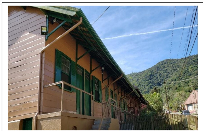
Figura 5. Vista da fachada principal da edificação com pintura recente. Avenida Manoel Ferraz de Campos Salles, 451-454. Foto SK, 19.7.2021
