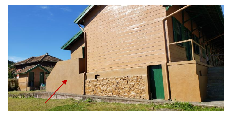
Figura 8. Fachada lateral da edificação sita à Avenida Manoel Ferraz de Campos Salles nº451. Observe-se o embasamento em alvenaria, pedras e gateira pintados. Foto SK, 19.07.2021.
