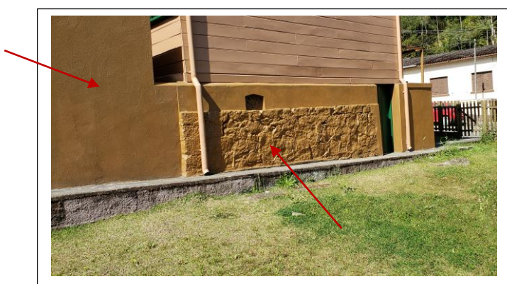
Figura 9. Detalhe da fachada lateral da edificação sita à Avenida Manoel Ferraz de Campos Salles nº451. Observe-se pedras pintadas, bem como parte da alvenaria da fachada lateral também pintada na cor do embasamento. Foto SK, 19.07.2021.
