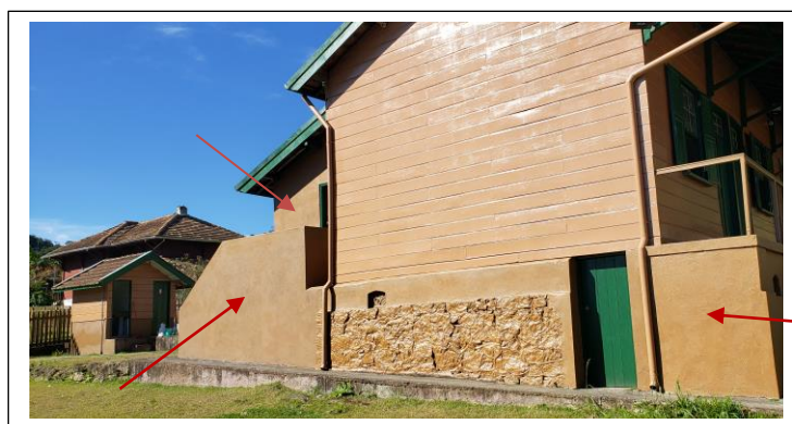
Figura 7. Fachada lateral, com destaque para a pintura da barra da fachada, pedras e fachada em alvenaria pintada da mesma cor – bronze olímpico. Avenida Manoel Ferraz de Campos Salles nº451. Foto SK, 19.07.2021.
