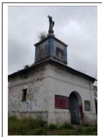
Foto 16 a 18. Vistas laterais e frontal da capela, com crescimento de vegetação no telhado, no suporte da estátua e na estátua. Pichações em todas as faces da edificação. 09.06.2021.
