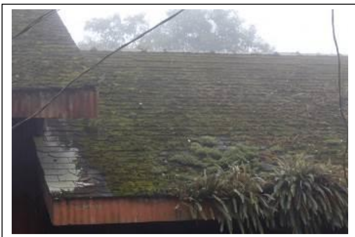
Foto 29 e 30. Edificações – caminho do Hospital Velho nºs 346, 347, 348 e 349. Observando-se a quantidade de material vegetal sobre o telhado, 09.06.2021.
