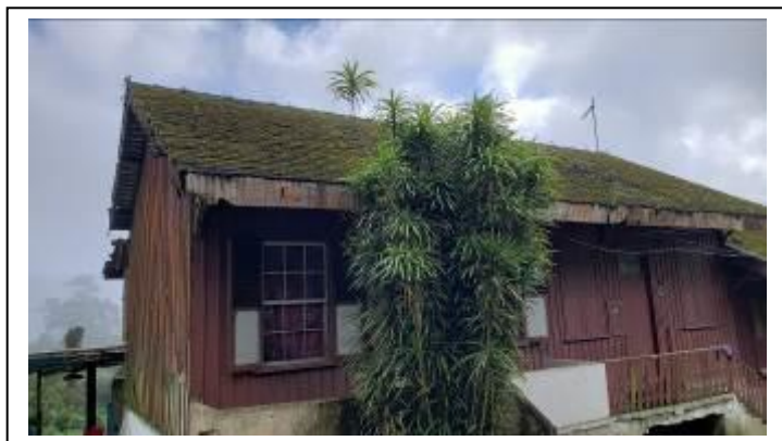
Foto 27 e 28. Edificações - Caminho do Hospital Velho nºs 346, 347, 348 e 349. Vistas gerais, 09.06.2021.
