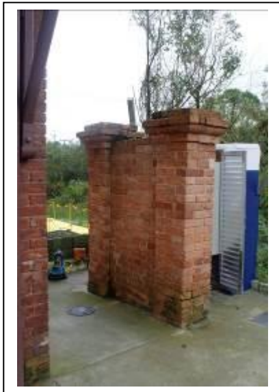
Foto 10. Detalhe do anteparo dos antigos sanitários e, ao fundo, e separado do anteparo foi instalada uma cabina de força, Estação de Campo Grande, 09.06.2021.
