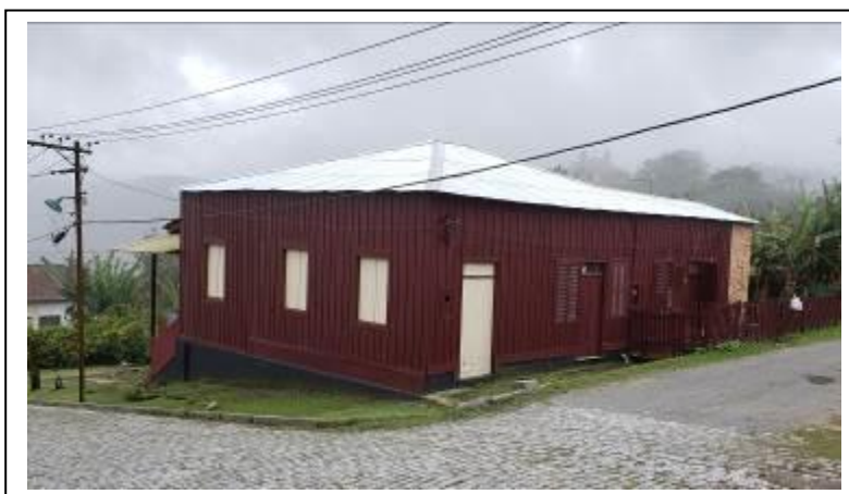
Foto 42. Vista lateral e da fachada da edificação, Rua Direita, 338, 09.06.2021.
