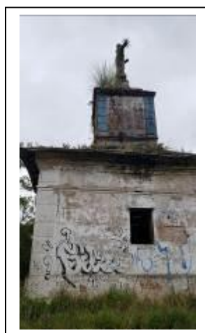
Foto 16 a 18. Vistas laterais e frontal da capela, com crescimento de vegetação no telhado, no suporte da estátua e na estátua. Pichações em todas as faces da edificação. 09.06.2021.
