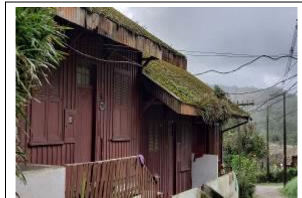
Foto 29 e 30. Edificações – caminho do Hospital Velho nºs 346, 347, 348 e 349. Observando-se a quantidade de material vegetal sobre o telhado, 09.06.2021.
