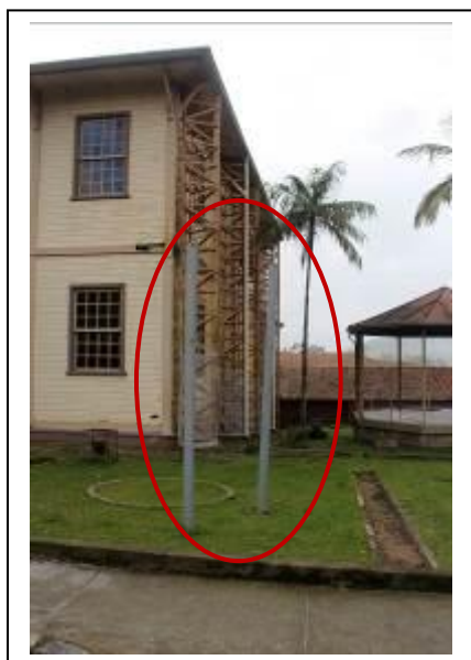
Foto 46. Vista de suportes para placa informativa, tendo sido retirada, 09.06.2021.
