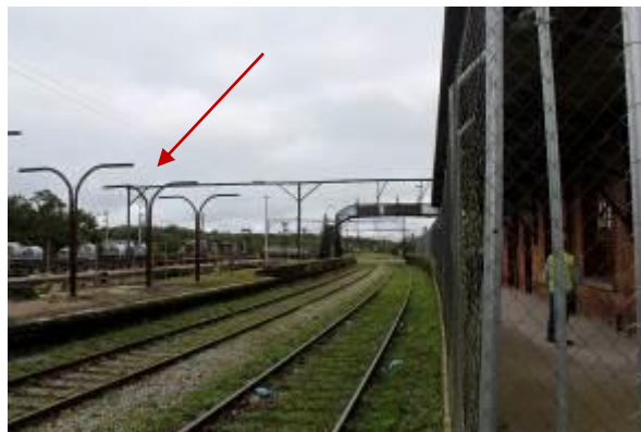
Foto 11. Estrutura metálica da plataforma central da Estação de Campo Grande, 09.06.2021.
