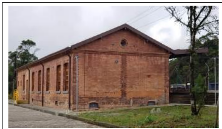
Foto 1. Vista da lateral e fachada anterior da Estação de Campo Grande. 09.06.2021.
