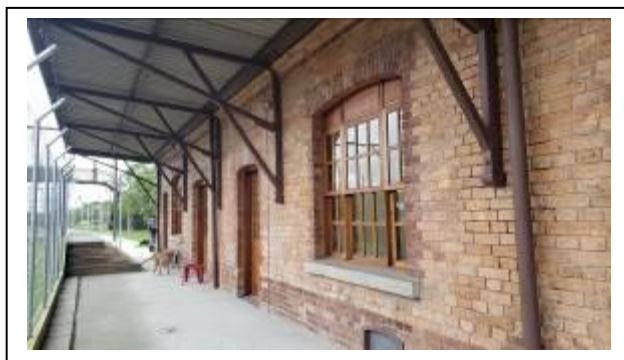
Foto 2 – vista da fachada posterior da Estação de Campo Grande. 09.06.2021.
