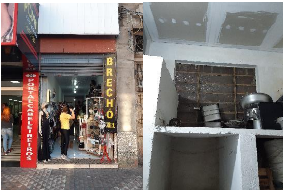
Imagens34 e 35: Construção no corredor de servidão e fechamento de aberturas do pavimento inferior
