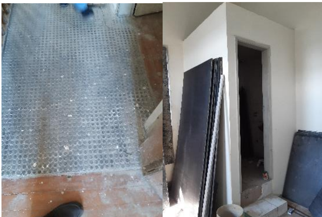
Imagens32 e 33: Sobreposição de piso de borracha sobre piso de madeira e compartimentalização
