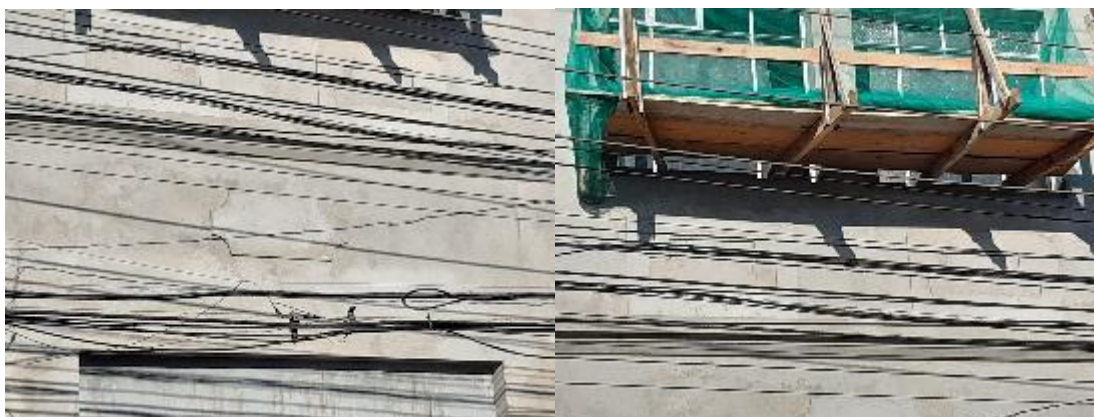
Imagens 12 e 13: Detalhe de execução de ornamentos geométricos da fachada da Av. Queiroz dos Santos
