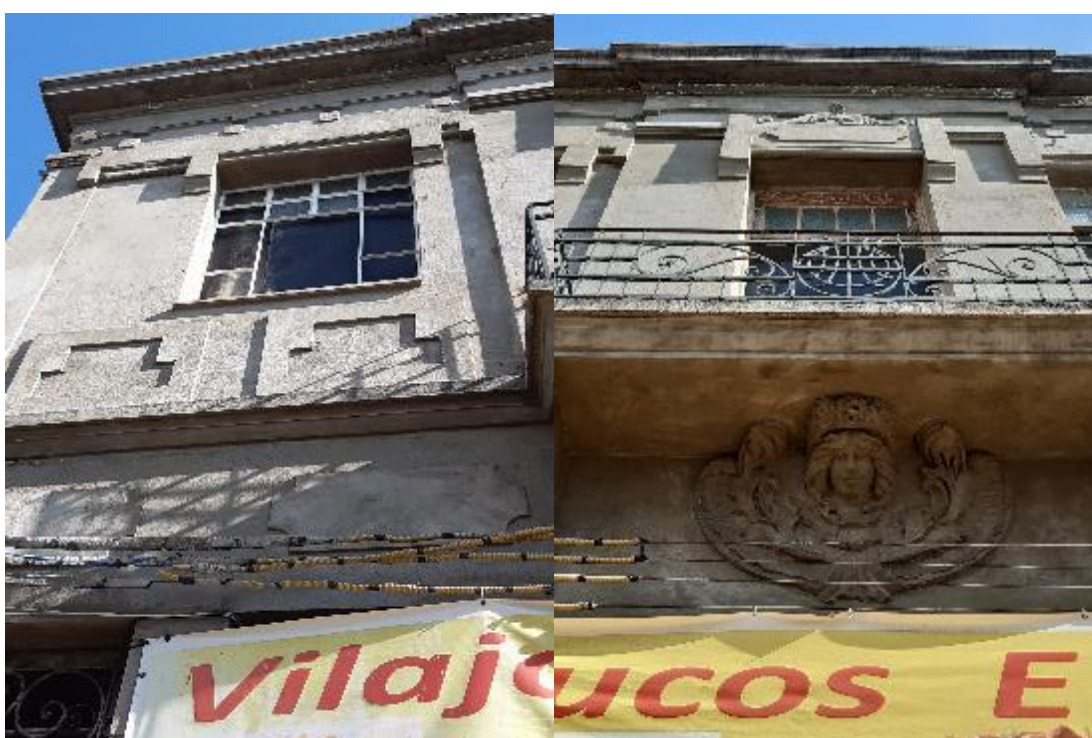
Imagens16 e 17: Detalhe de execução de ornamentos da fachada da Rua Bernardino de Campos
