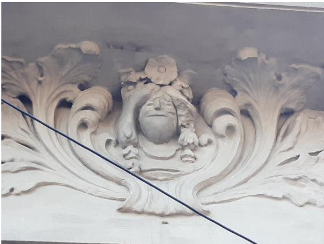
Imagem21: Detalhe de execução de mascarão voltado para da Rua Bernardino de Campos
