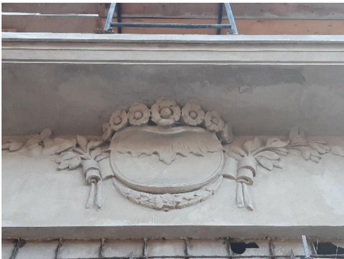
Imagem23: Detalhe de execução de guirlanda voltada para da Rua Bernardino de Campos
