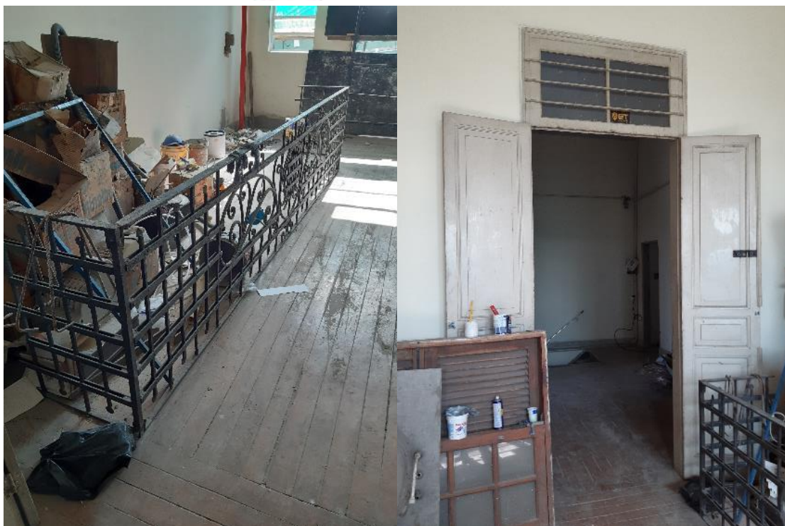
Imagens28 e 29: Detalhe de elementos retirados para restauro (guarda corpo de ferro e portas internas)
