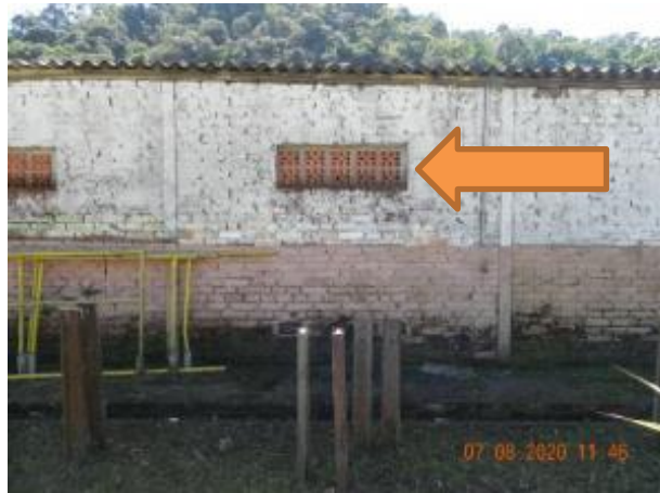
Vãos com tijolos vazados e pilar em trilho – ago/20
