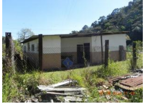
Vista da face leste – ago/20
