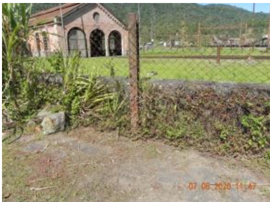
Muro de pedra (rente um alambrado) – ago/20
