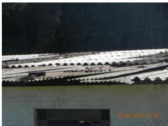
Telhas com dimensões diferentes – ago/20
