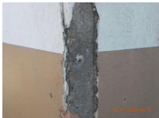
Argamassa se destacou onde há um pilar trilho – ago/20
