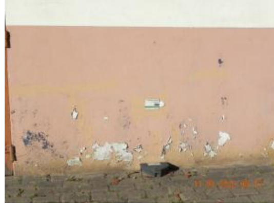
Área externa - repintura destacando – ago/20
