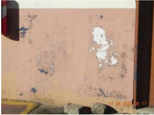
Área externa - repintura destacando – ago/20
