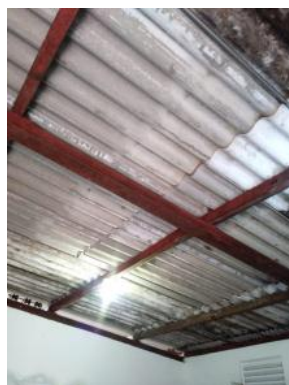
Telhado (vista interna) – ago/20
