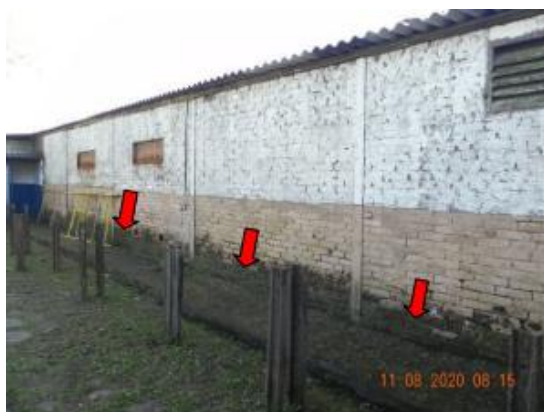
Trecho com ausência de argamassa – ago/20
