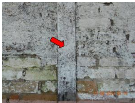
Pilar em trilho – ago/20
