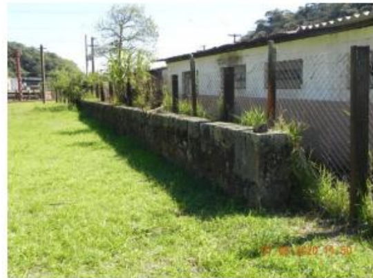
Trecho de muro de pedra (Face Sul)
