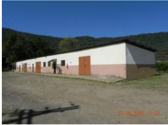
Vista do prédio – MRS - ago/20
