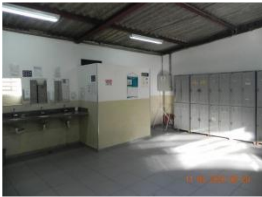
Área interna – pintura – ago/20
