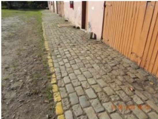
Trecho de piso de pedra paralelepípedo (Face Norte)
