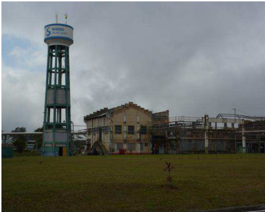
Foto da Caixa d'água (2016)
