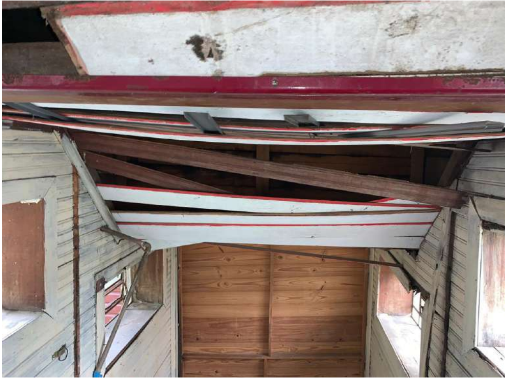
Situação precária e crítica do forro que liga as duas residências de madeira
