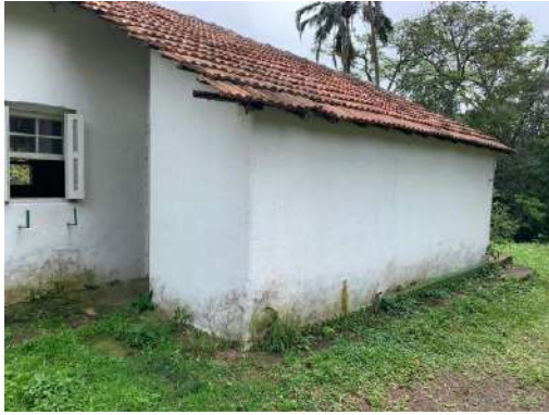
Vista da parte externa – observa-se problemas na estrutura do telhado.
