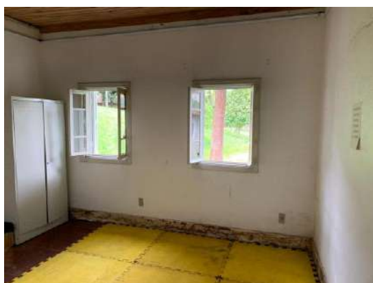
Observam-se problemas no piso, forro de madeira e necessidade de pintura.
