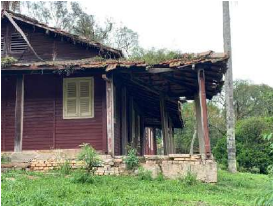
Vista da parte externa – observa-se problemas na estrutura do telhado.
