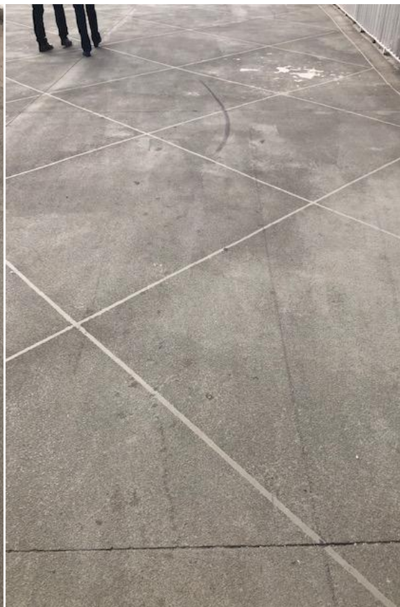
Figura 11 - Camada de revestimento sobre piso da passarela Luso-brasileira.
