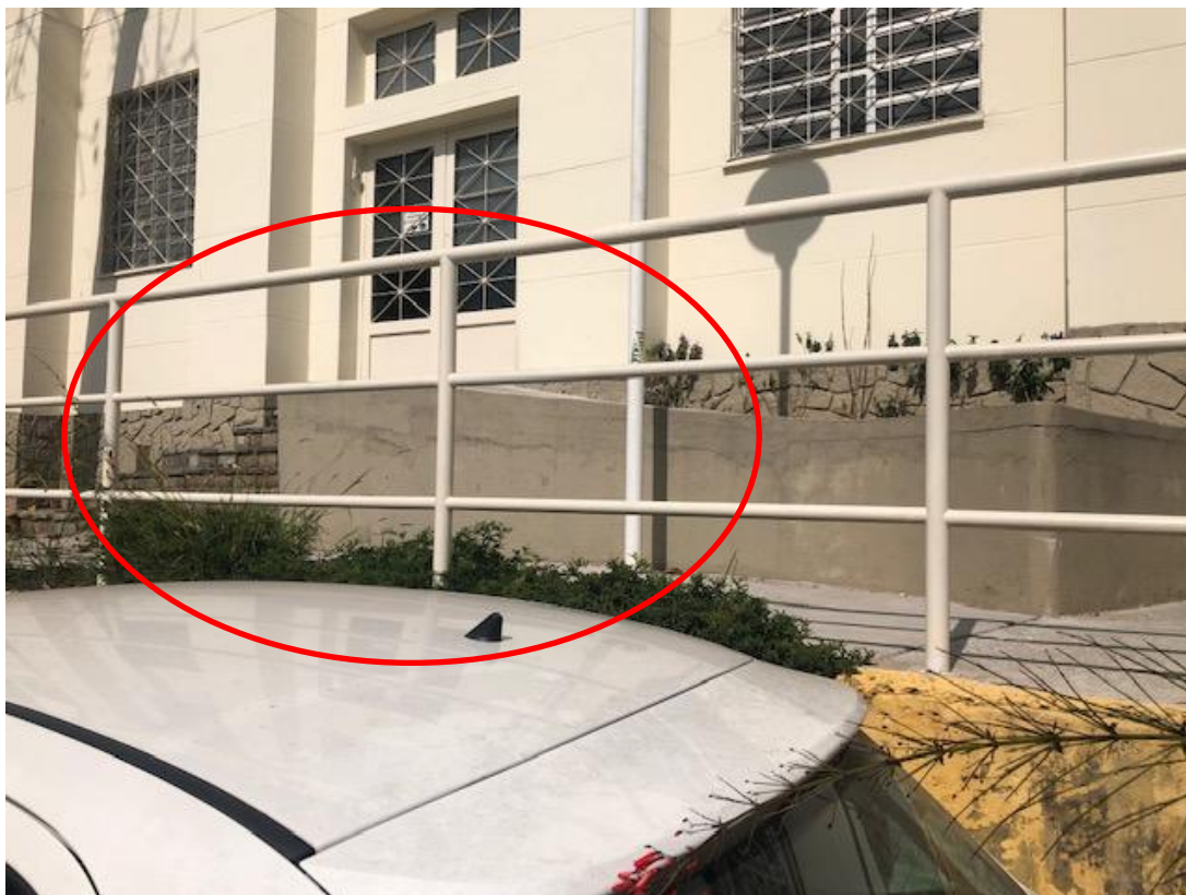
Figura 12 - Rampa executada sobre parte da escada do prédio dos Correios.
