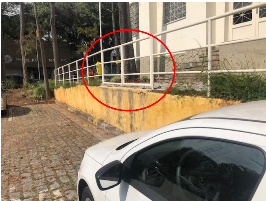
Figura 13 - Portão antes utilizado para carga e descarga dos Correios.
