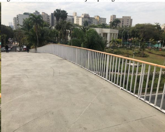
Figura 7 - Vista da passarela e Praça IV Centenário.
