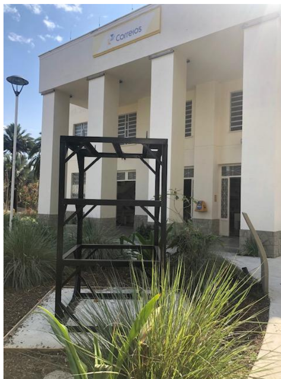
Imagem 2 - Estrutura para instalação da escultura de João Ramalho, notar a altura da estrutura em relação ao edifício tombado, o que interferirá visivelmente na fachada após seu fechamento e a instalação da escultura. Processo 39.800/1999.
