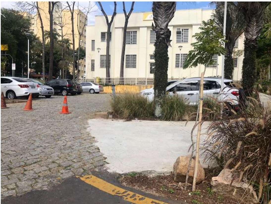
Figura 24 - Área de estacionamento dos Correios, à direita novo acesso para carga e descarga e abaixo asfalto para acesso de veículos sobre a Praça.
