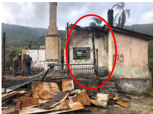
Figura 5 – Corpo em alvenaria - face oeste.
