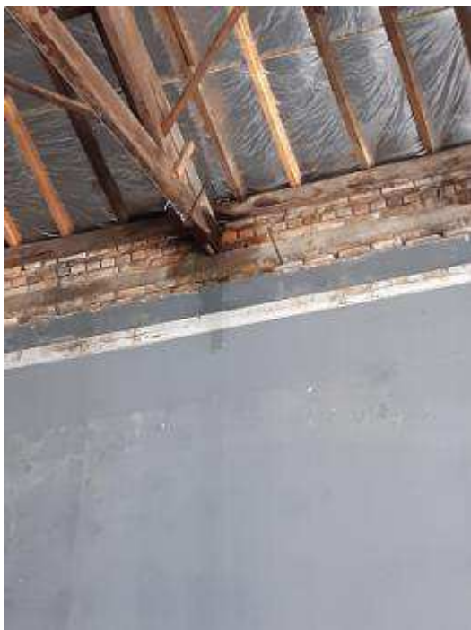
Excesso de umidade nos pontos de apoio das tesouras de madeira em função de infiltração.
