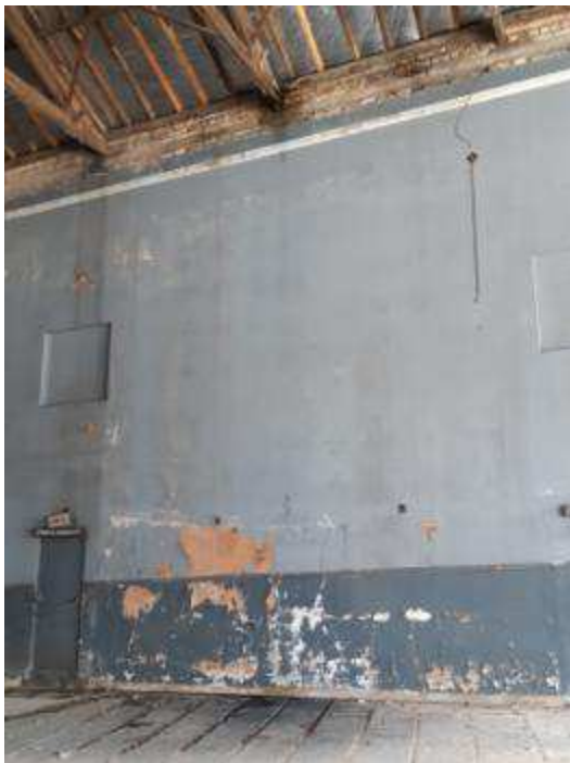
Excesso de umidade nos pontos de apoio das tesouras de madeira em função de infiltração.
