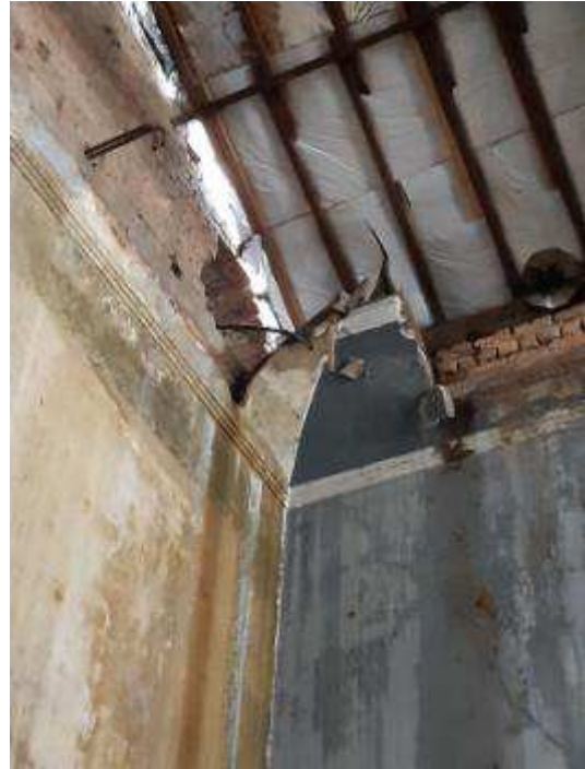
Comprometimento da sanca junto à boca de cena em função de infiltração
