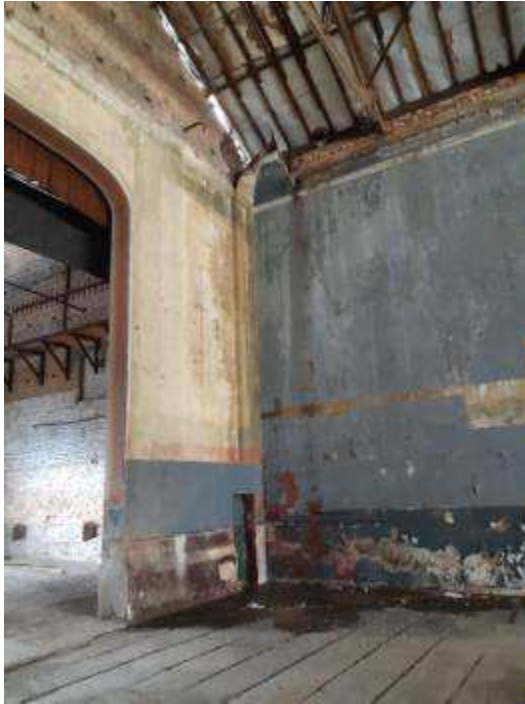
Comprometimento da sanca junto à boca de cena em função de infiltração
