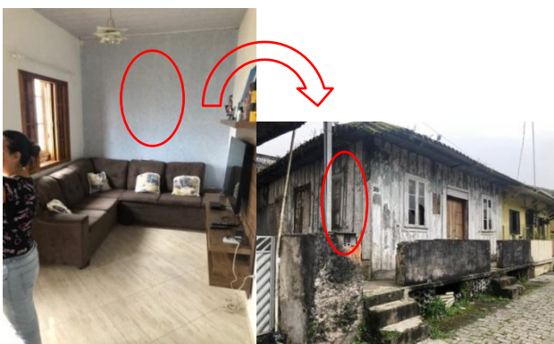
Foto 20: Sala de estar, a parede em alvenaria eliminou a janela da fachada lateral.
