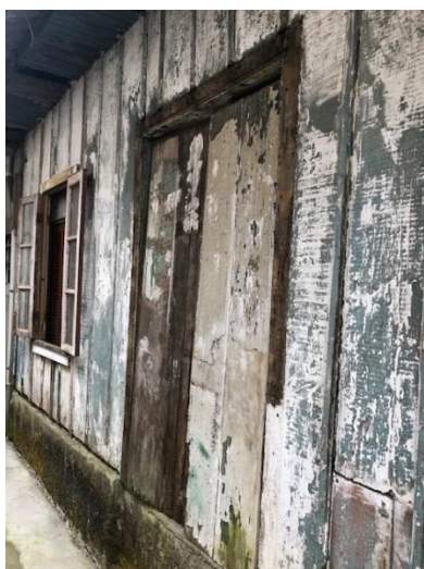
Foto 5: Fachada lateral, porta aberta em momento não determinado.
