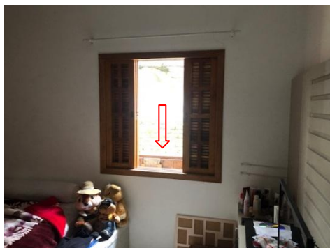
Foto 15: Dormitório, notar esquadria instalada na alvenaria construída interna à fachada de madeira.
