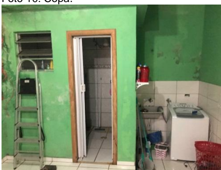
Foto 12: Sanitário da área de serviços.
