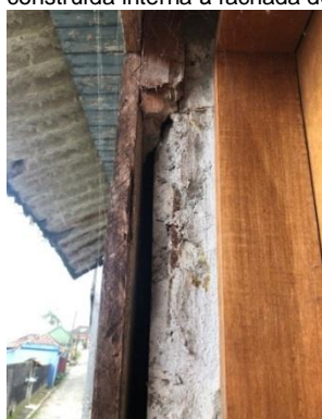
Foto 21: Porta da fachada principal, notar alvenaria construída internamente à madeira da fachada.
