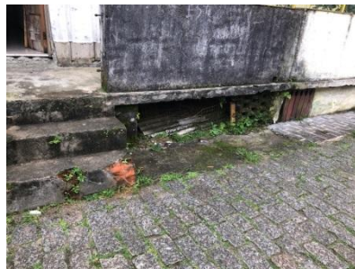
Foto 4: Detalhe do respiro do porão.
