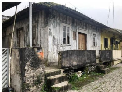
Foto 1 : Fachada frontal e parte da lateral. Rua João Antunes, 29
