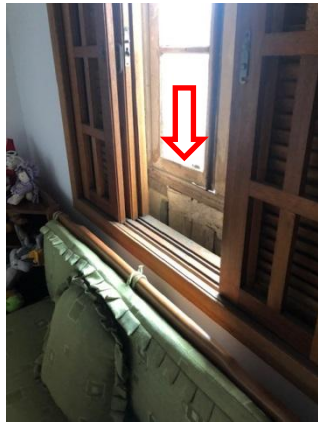
Foto 19: Sala de jantar, notar esquadria instalada na alvenaria construída interna à fachada de madeira.
