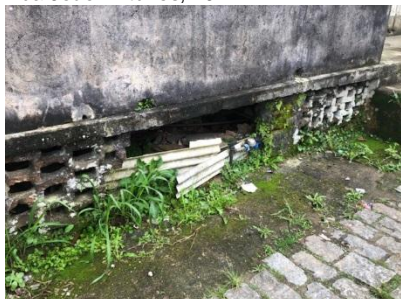
Foto 3: Detalhe do respiro do porão.
