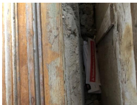
Foto 23: Batente da nova janela instalada na parede de alvenaria e a fachada de madeira.
