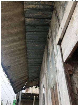
Foto 8: Parte superior da fachada principal.
