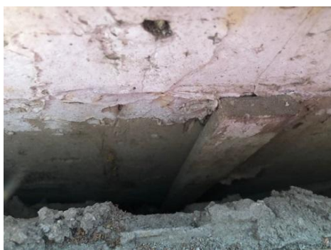
Foto 22: Detalhe da alvenaria construída interna à fachada em madeira.
