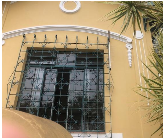
Foto 4 Detalhe da janela, fachada frontal. Foto: CT 090419
