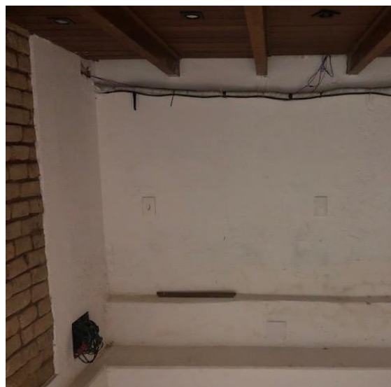
Foto 17 Porão Foto: CT 09/04/2019.
