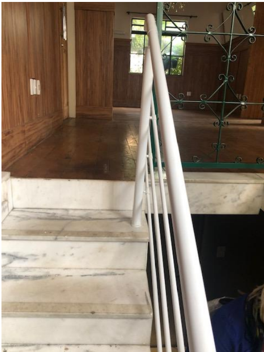
Foto 11 Salão e acesso ao porão Foto: CT 09/04/2019.
