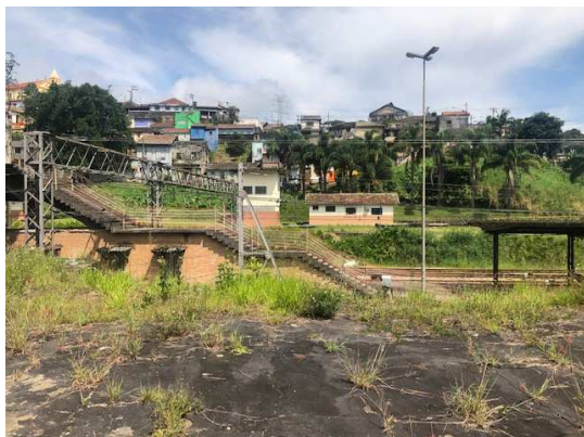
Galpões no pé do morro da Parte Alta ao fundo
