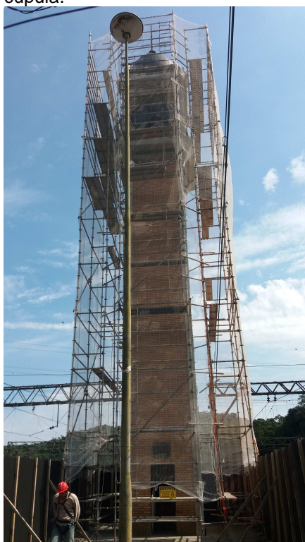
Foto: Restauo da Torre do Relógio
