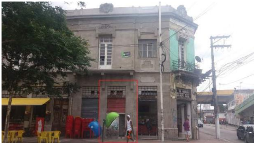
Fechamento parcial em alvenaria de uma das portas da fachada da Av. Bernardino de Campos
