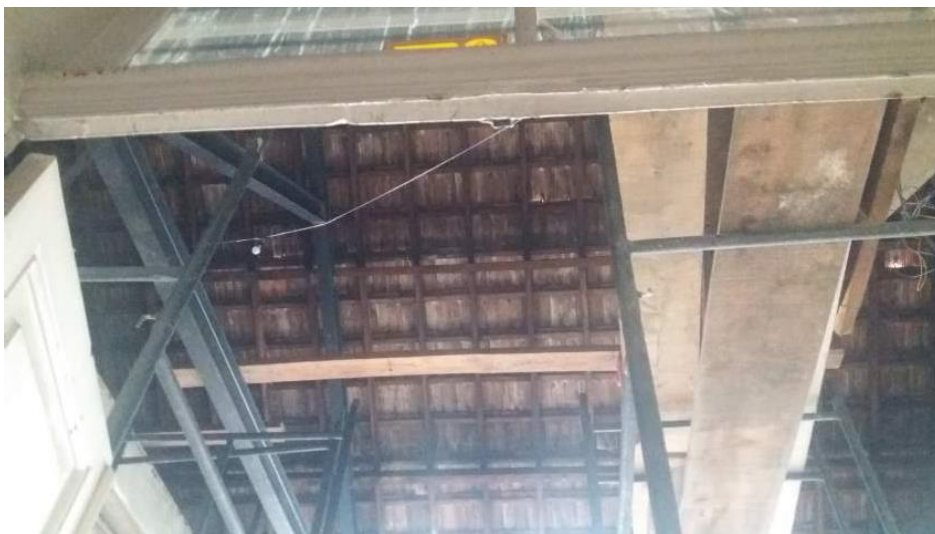
Substituição de peças em madeira da estrutura do telhado por peças metálicas
