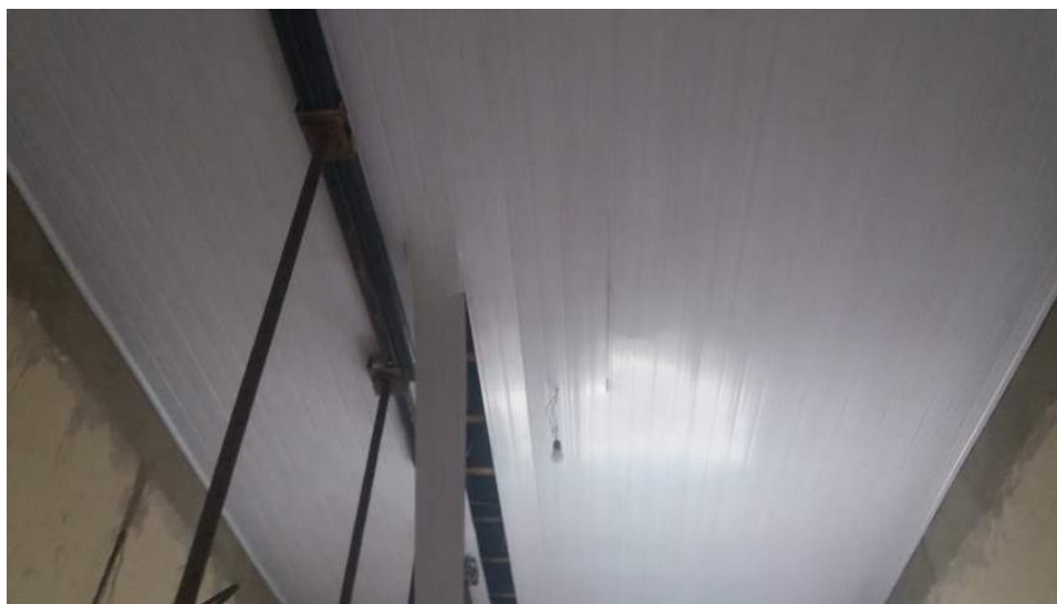
Substituição do forro de madeira por PVC
