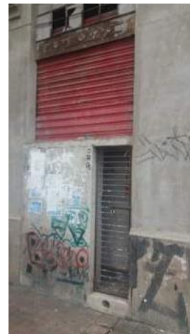
Fechamento parcial em alvenaria de uma das portas da fachada da Av. Bernardino de Campos
