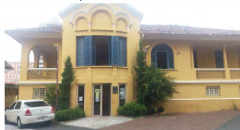
VISTA DA FACHADA
