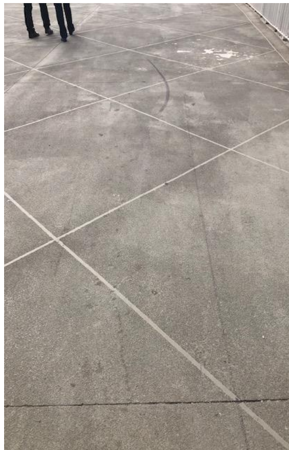
Figura 11 - Camada de revestimento sobre piso da passarela Luso-brasileira.
