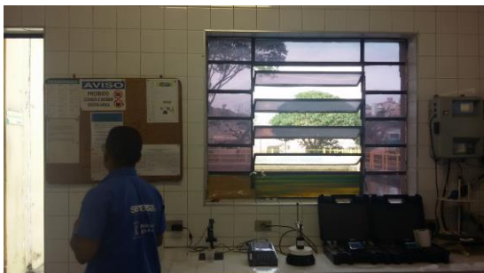
Sala de operação. Foto: CT 12/09/18
