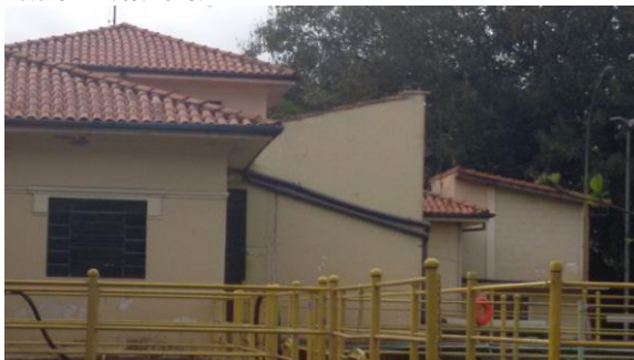
Parte da Fachada lateral direita Foto: CT 12/09/18.
