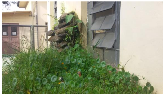
Detalhe fachada lateral esquerda, área do “aquário”. Foto: CT 12/09/2018.
