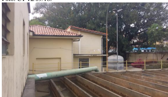
Lateral – tanque das chincanas Foto CT 12/09/18.
