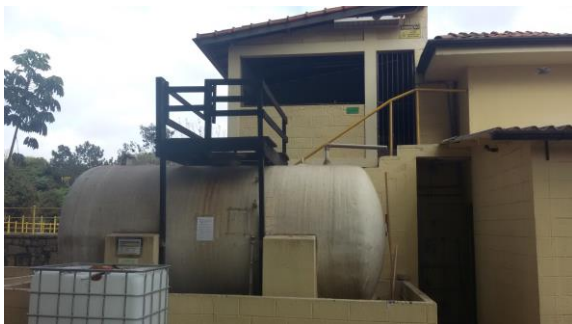
Fachada lateral esquerda – Sala de Mistura. Foto: CT 12/09/18.
