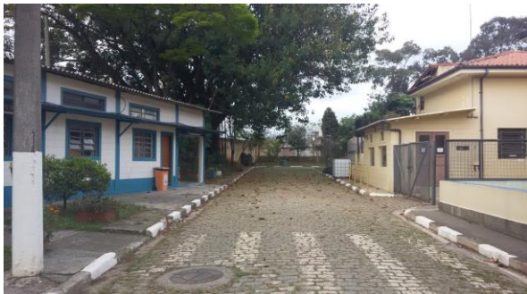
Arruamento de paralelepípedo, fachada lateral esquerda e à direita Salas de reuniões e “museu” da ETA Guarará.
