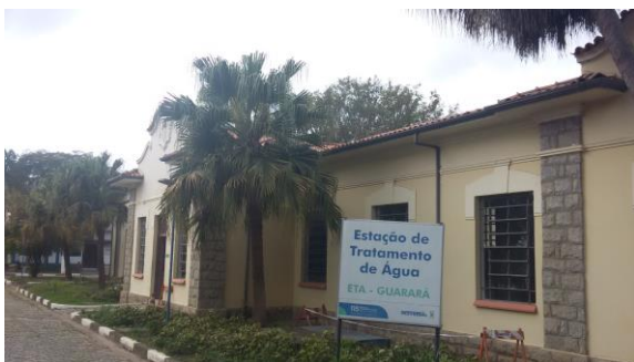
Parte da fachada principal, lado direito. Foto CT 12/09/2018.
