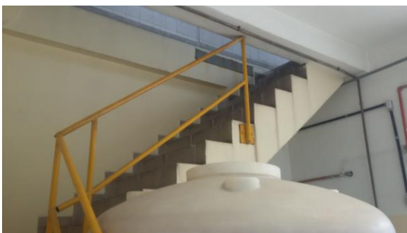
Escada de acesso à Sala de Dosagem Foto: CT 12/09/2018.
