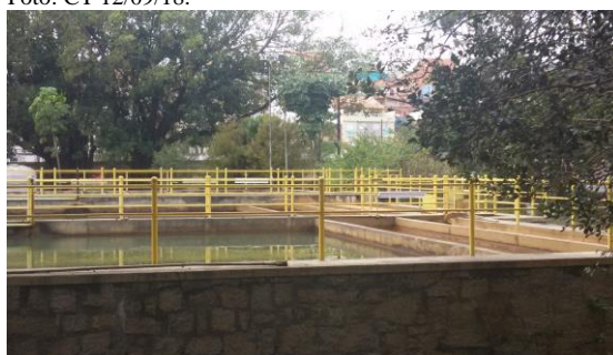
Vista dos tanques – lateral direita
