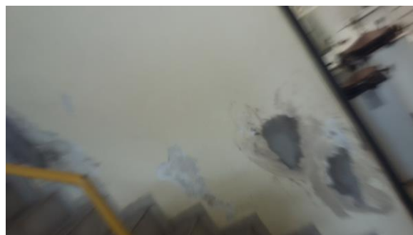
Parede da escada de acesso Sala de Dosagem. Foto: CT 12/09/2018.
