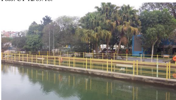
Tanque de decantação. CT 12/09/18.
