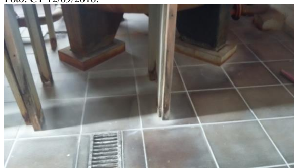
Piso – Sala de Dosagem, piso cerâmico com a cor alterada Foto: CT 12/09/2018.
