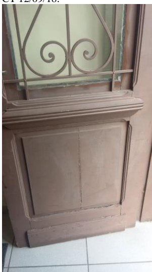
Detalhe da porta de entrada Foto: CT 12/09/2018
