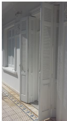
Parte da varanda superior, detalhe da porta. Foto CTPC 26/04/2018.
