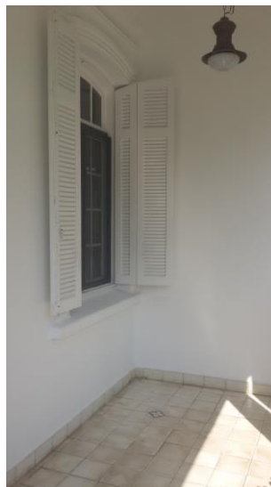
Varanda da entrada principal Foto CTPC 26/04/2018.
