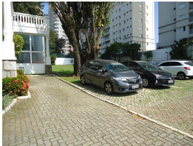
Parte da fachada lateral direita do imóvel e área utilizada como estacionamento, houve a instalação de piso concregrama. Foto CTPC 26/04/2018.
