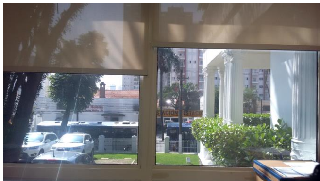
Varanda inferior com fechamento em vidro, hoje utilizada como sala administrativa do laboratório, ao fundo Av D. Pedro II. Foto CTPC 26/04/2018.
