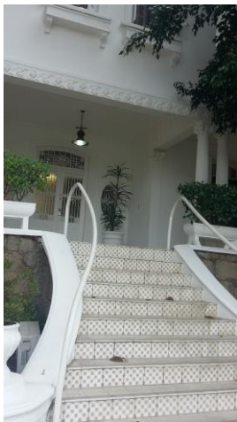
Parte da fachada principal, escada. Foto CTPC 26/04/2018.
