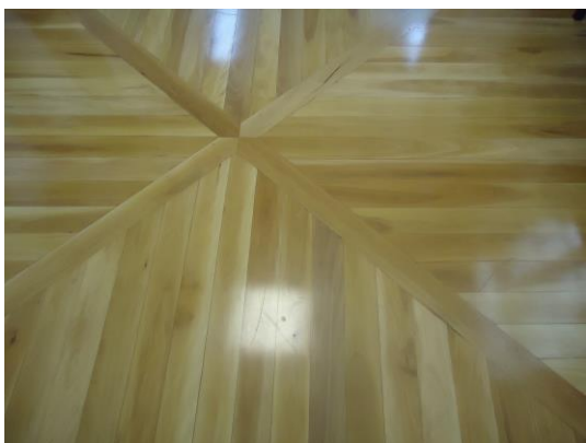
Detalhe do piso do saguão de atendimento, feito em 2012, conforme fl. 239 do PA 35.105. Foto CTPC 26/04/2018.
