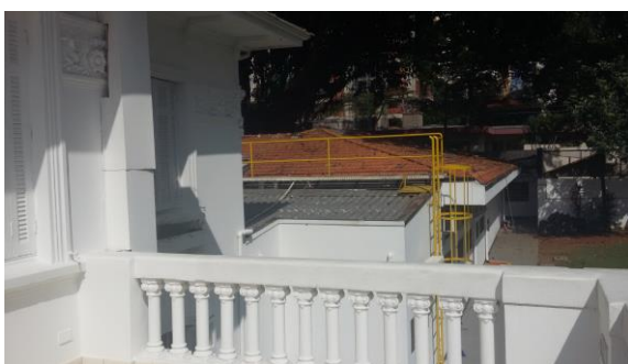
Parte da varanda superior/ fachada, ao fundo o anexo. Foto CTPC 26/04/2018.
