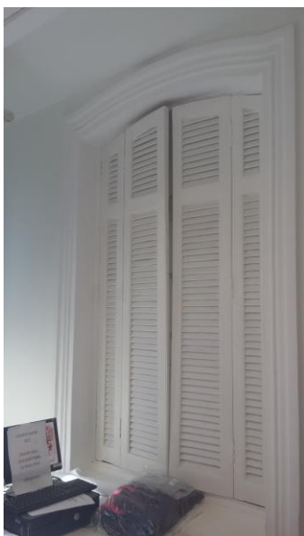
Foto da varanda inferior, parte da parede externa da casa. Foto CTPC 26/04/2018.
