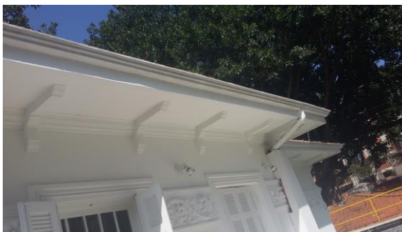
Detalhes externos da fachada lateral direita - varanda superior. Foto CTPC 26/04/2018.
